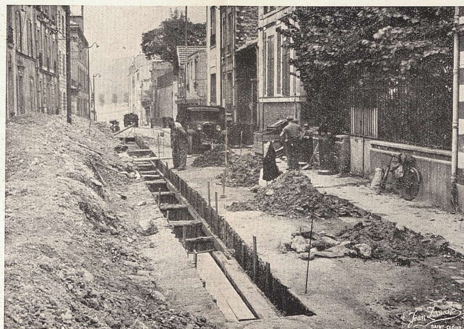
Les travaux, rue de la Paix
