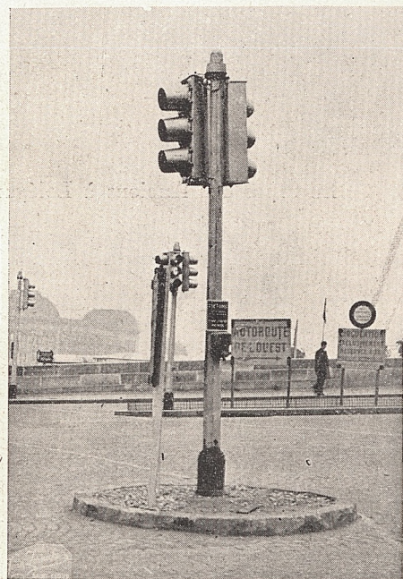
La signalisation Le passage lumineux de l'avenue du Palais
