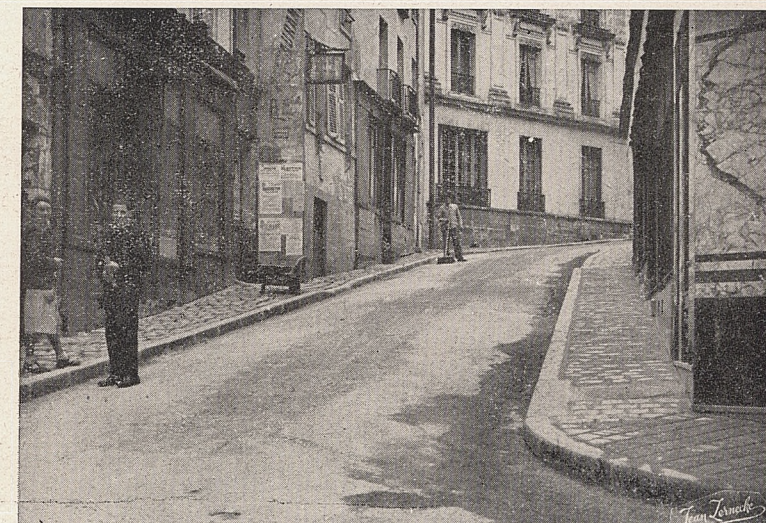
La rue Royale après les travaux
