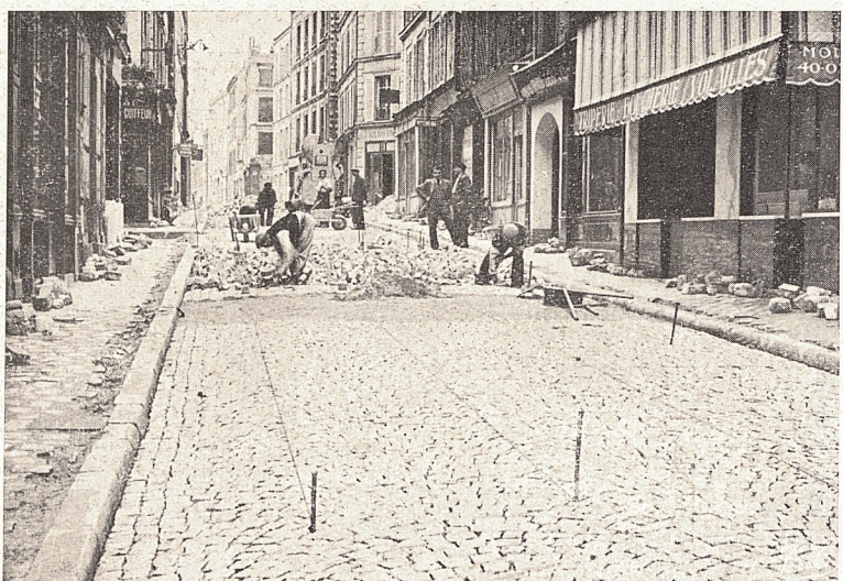
La rue d'Orléans en cours de réfection
