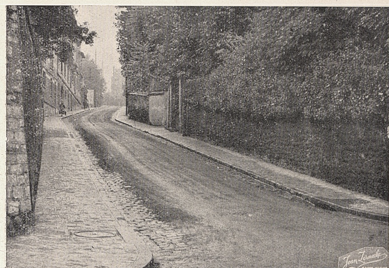
La rue Coutureau après remise en état
