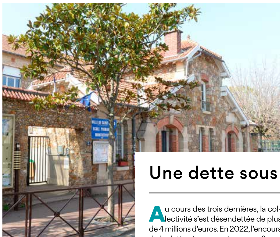
Travaux à l'école élémentaire Montretout.
